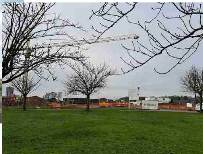
Solaire - Eixample XII à Marcinelle
